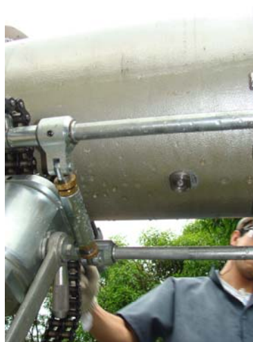
Figura 9 – Tubulação reparada com MR
