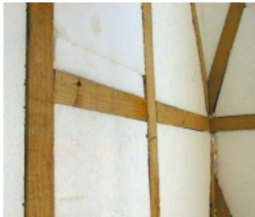
Figura 3: Aislante en el panel exterior
