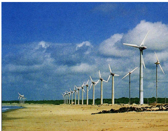
Figura 4.6a. Fazenda eólica instalada numa região costeira.
