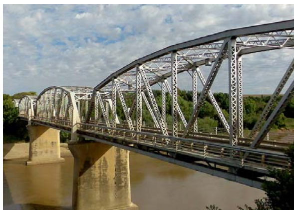
Figura 6. The General Hertzog Bridge, sobre o Rio Orange, na África do Sul: exemplo de ponte cujas treliças estão acima de seu leito de passagem (Harington, 2006).
