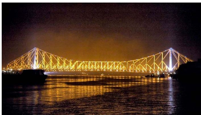
Figura 1. Howrah Bridge, em Calcutá, na Índia: exemplo de ponte cantilever (ISI, 2010).
