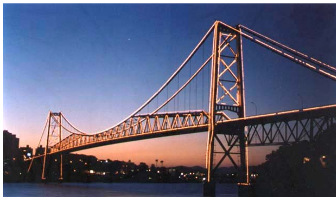
Figura 3. Ponte Hercílio Luz, em Florianópolis, Brasil: exemplo de ponte pênsil (ImageShack, 2010).
