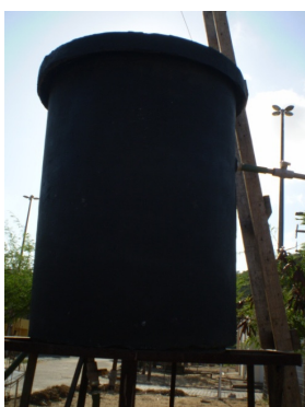
Figura 2. Reservatório térmico do sistema de aquecimento – RT200.
