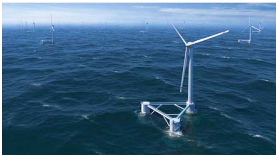
Figura 1: Windfloat: Turbinas eólicas flutuantes.
