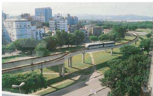
Figura 1. Linha piloto do sistema Aeromóvel.
