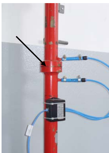
Figura 3. Placa de Orifício de Ar
